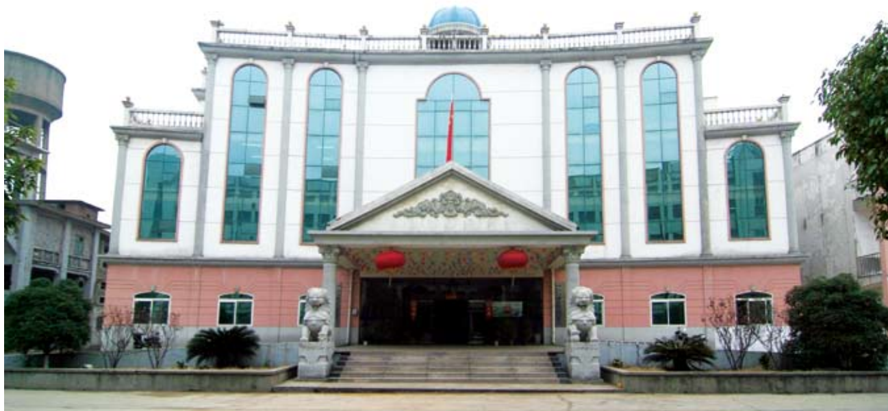
顺外村办公楼
