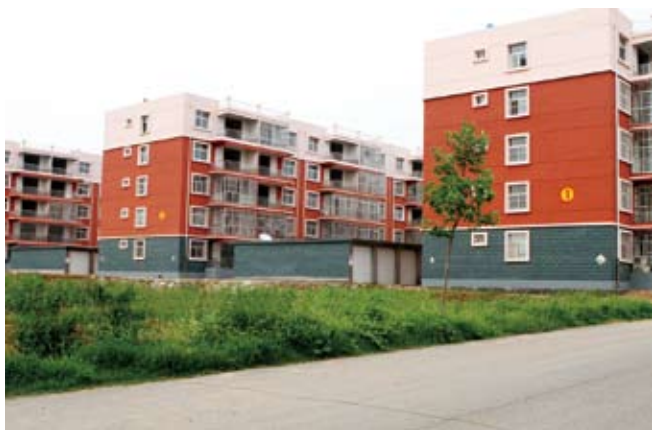
洙边社区住宅楼
