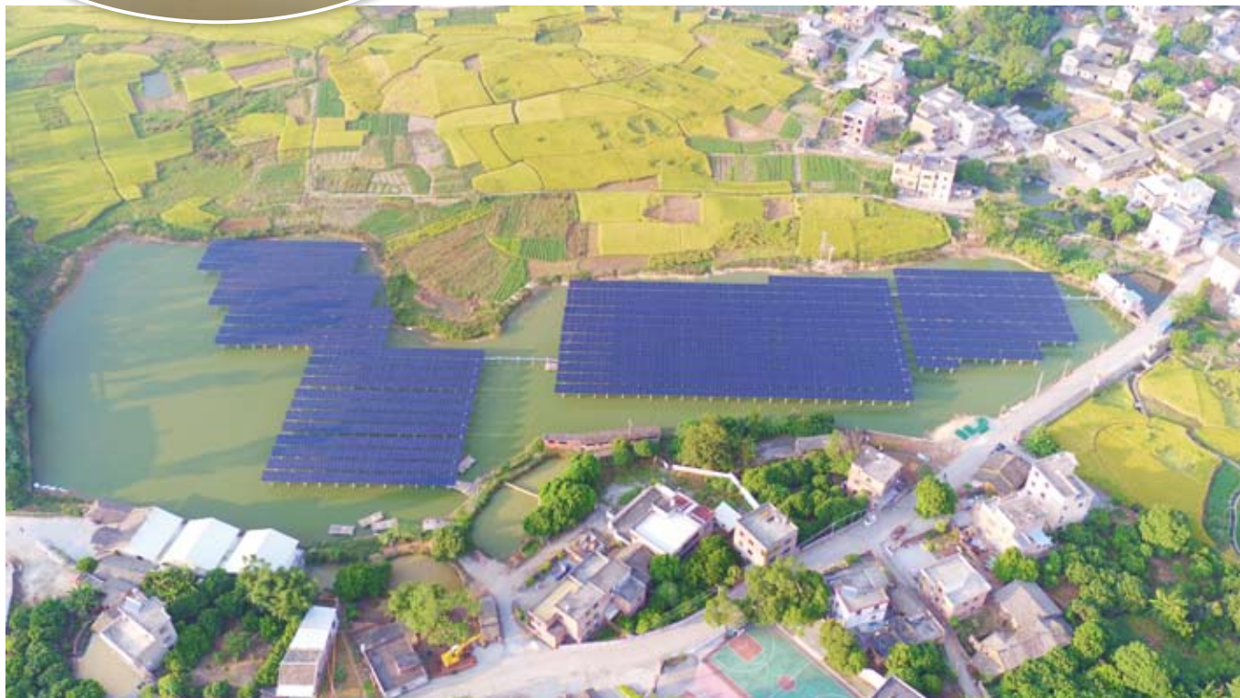
已经建成的“渔光系统”
