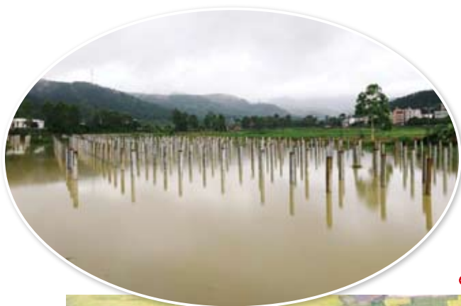
正在建设的“渔光系统”
